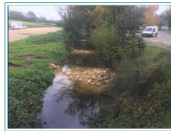
Ruisseau 1 mois après les travaux
