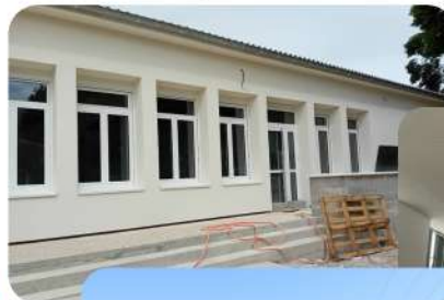
Travaux sur le pôle des Buissonnets .
