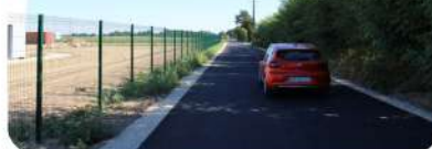
Travaux de Voirie devant écolience.
