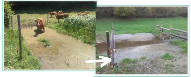
Passage à gué avant et après travaux
