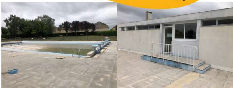
La piscine de Valence-en-Poitou va bénéficier de travaux afin de remettre le bassin en état et accueillir de nouveau le public.
