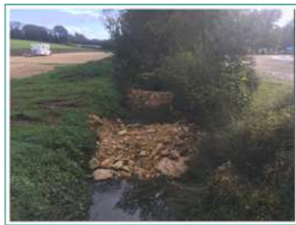
Ruisseau pendant les travaux
