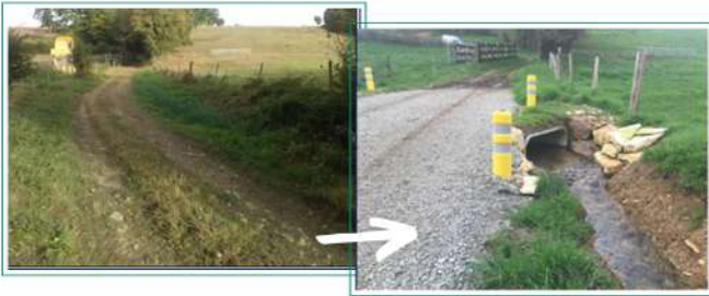
Pont cadre avant et après travaux (vue aval)
