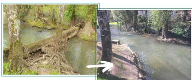
Ouvrage avant et après travaux
