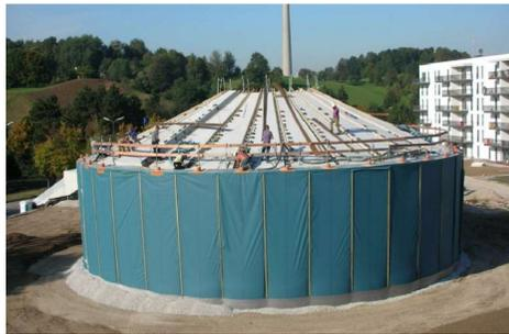
**BTES** : stockage avec sondes géothermiques
